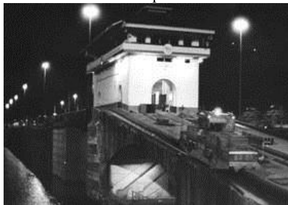
Мост, соединяющий Северную и Южную Америку. Панамский канал ночью. Электровоз тянущий судно из одного шлюза в следующий.
